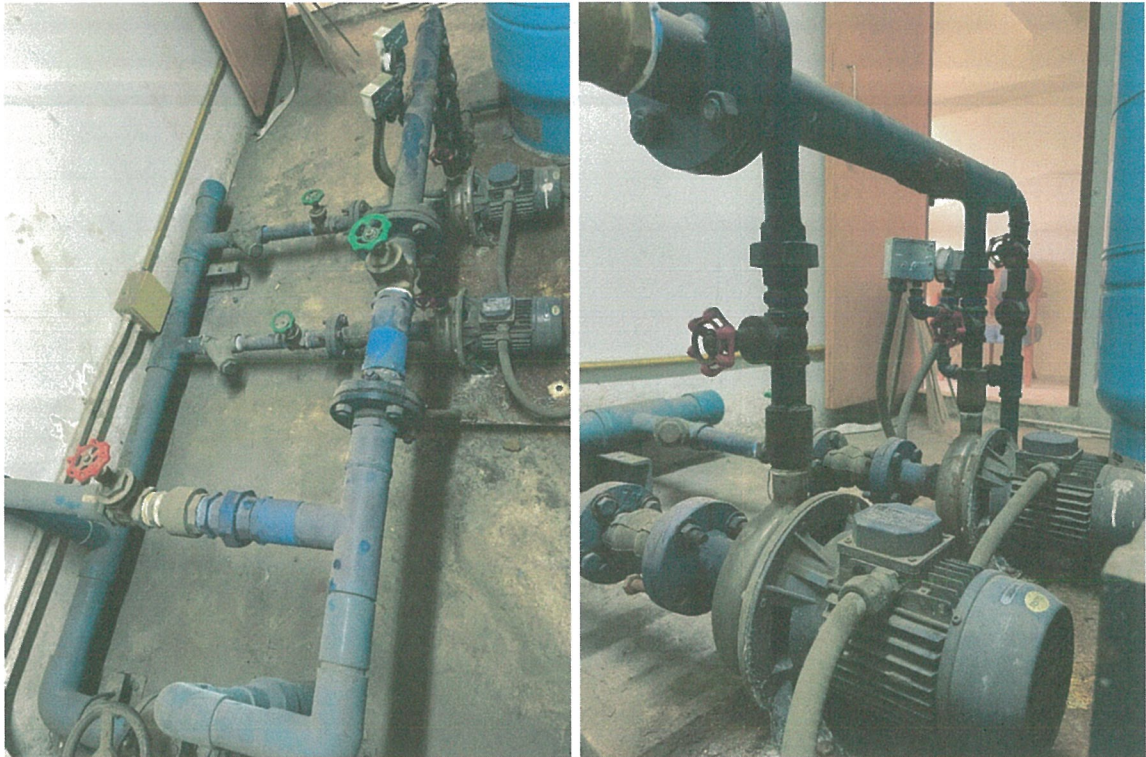
ภาพที่ 4 เครื่องสูบน้ำเพิ่มแรงดันของเดิม
